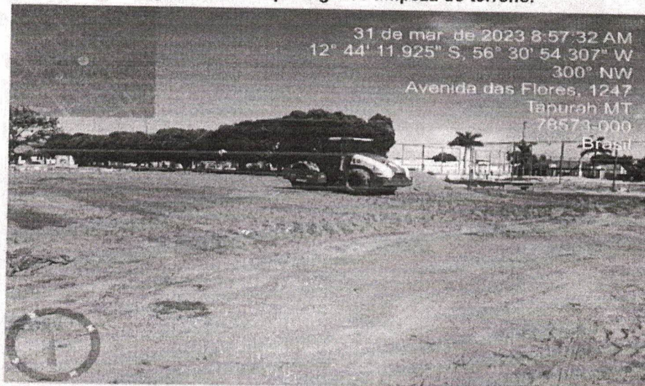
Figura 02 –Terraplanagem e limpeza do terreno.
